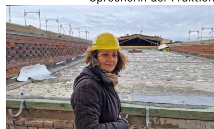
Stadträtin Anke Jäger auf dem Dach der Stadthalle, die sich aktuell in der Sanierung befindet.
