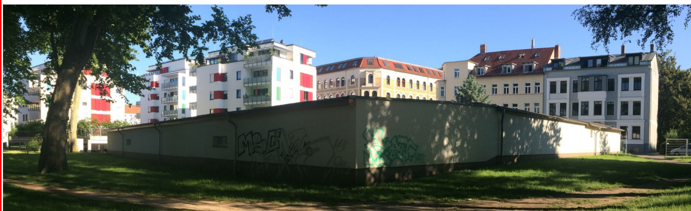
Dieser Flachbau in unmittelbarer Elbnähe beherbergt noch bis 2025 den ESV Lok, danach muss er einem Bauvorhaben der MWG weichen. OB Dr. Lutz Trümper meint: Eine Sanierung der Kegelanlage sei hier aufgrund der Hochwassergefährdung nicht vertretbar. Für die MWG scheint das so nicht zu gelten.
