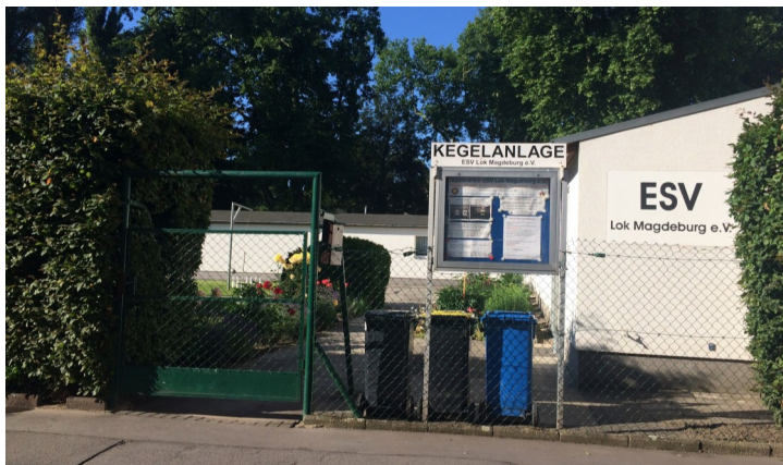
In der Lingnerstraße auf dem Werder steht das vom Hochwasser 2013 betroffene Vereinsgebäude des FSV Lok e.V.
