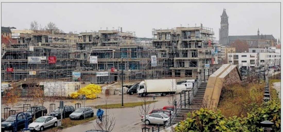
Am Elbebahnhof in Magdeburg wird kräftig gebaut – ein Beispiel für die dynamische Entwicklung der Stadt.
